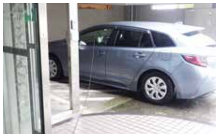
ハイブリッド車を非常電源として活用
